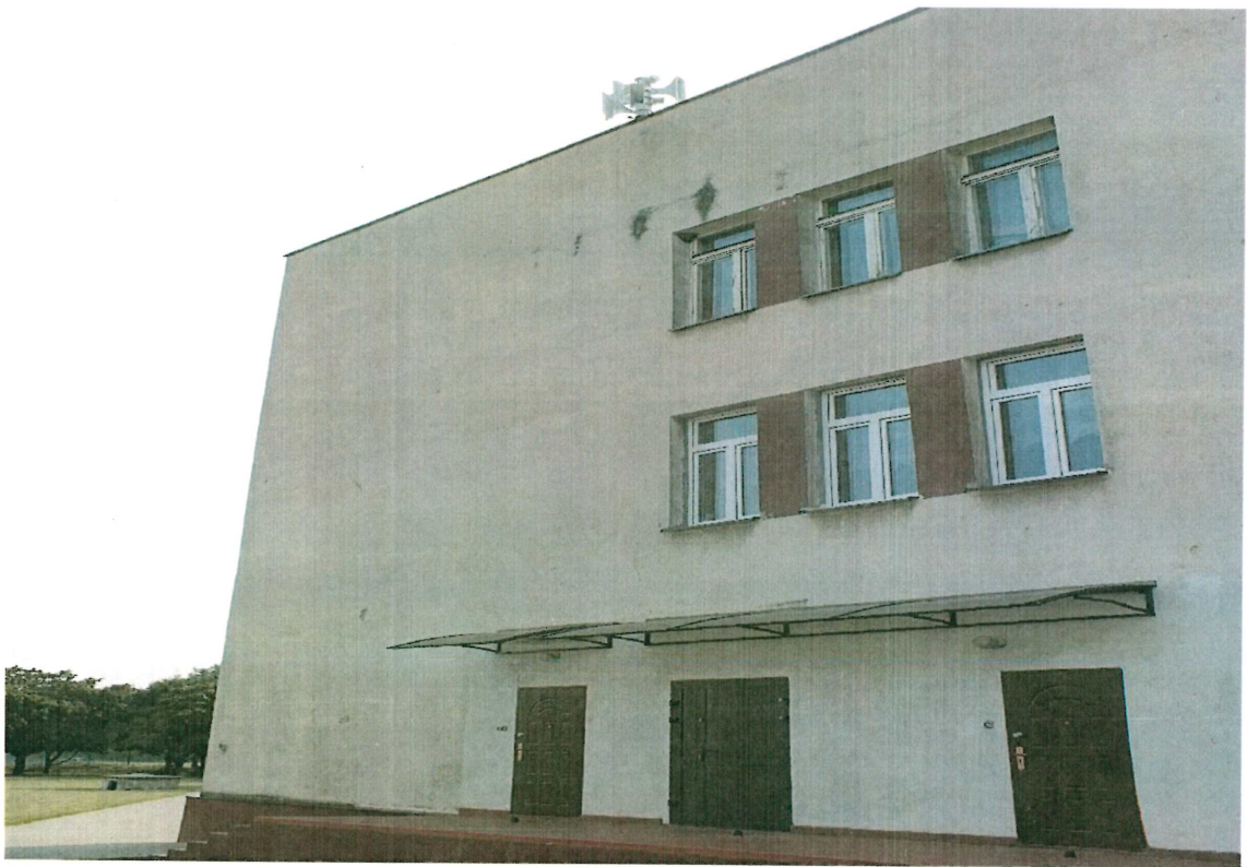
Syrena elektroniczna znajdująca się na budynku szkoły podstawowej nr 4.
