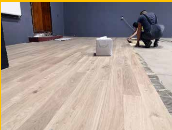
Prace remontowe sali kinowej w NOKu
