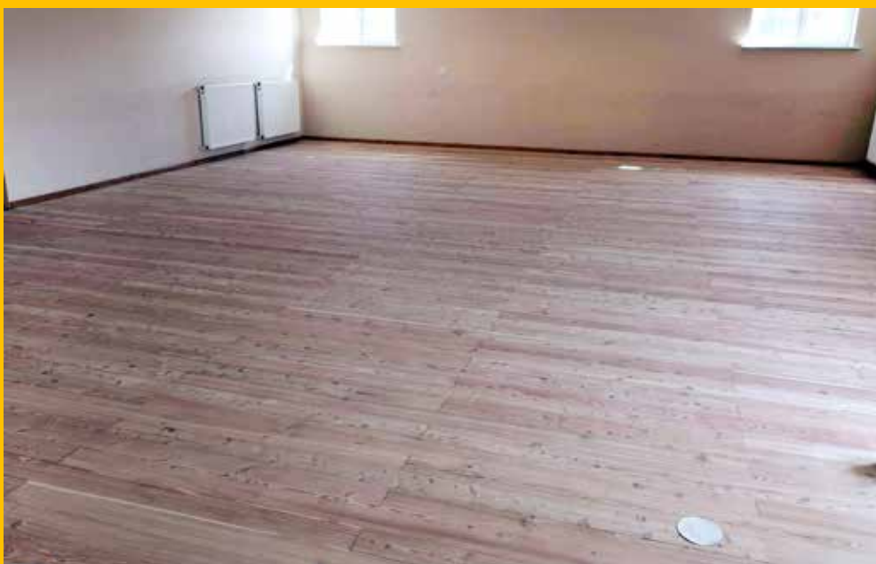
Remont pomieszczeń świetlicy w Sucharach
