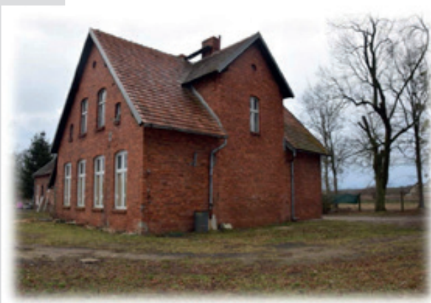
Modernizacja dachów świetlic w Chrzęstowie, Gorzenu i na wieży w parku Sobieskiego wartość: 15.010,31 zł z dotacji celowej
