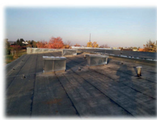
Modernizacja Wiejskiego Domu Kultury w Ślesinie wartość: 72.120,73 zł z dotacji celowej
