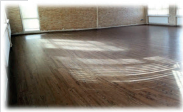
Modernizacja podłogi w jednej z sal WDK Paterek wartość: 18.468,11 zł z dotacji celowej
