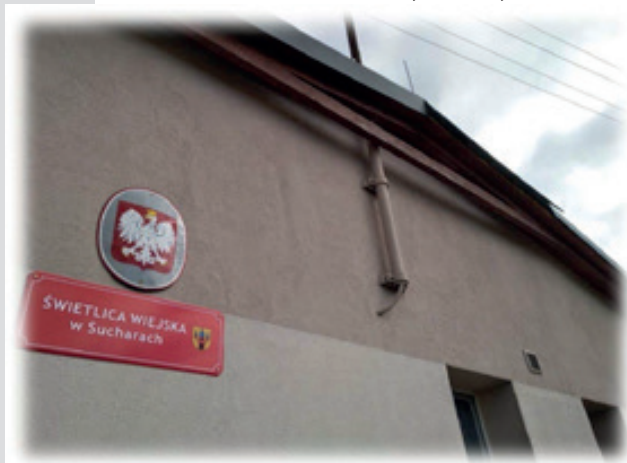
Modernizacja świetlicy wiejskiej w Sucharach wartość: 317.494,85 zł z dotacji celowej
