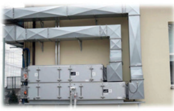
Montaż wentylacji na sali konferencyjnej NOK wartość: 108.344,23 zł, w tym: 100.000,00 z dotacji celowej i 8.344,23 ze środków własnych
