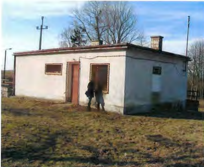
Fot. 3. Budynek w Kazinie
