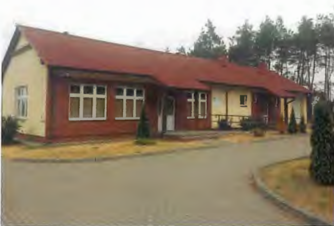
Fot.15. świetlica w Polichnie
