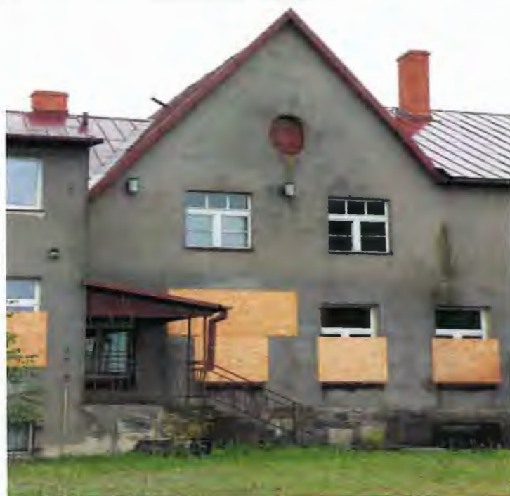
fot. 9. Obiekt w Paterku
