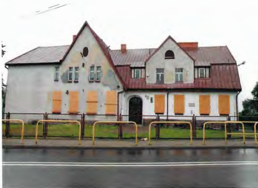
Fot.8. Obiekt w Paterku
