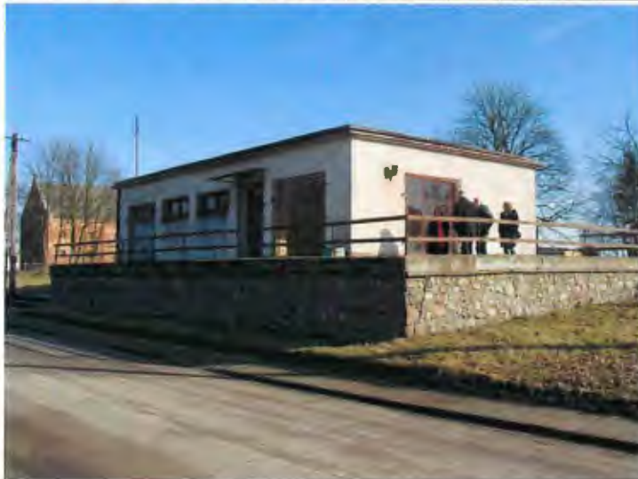
Fot. 4. Budynek w Kazinie
